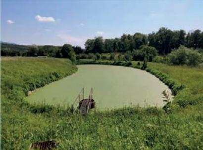
Micro-station d'épuration naturelle, permettant de filtrer les eaux usées puis les renvoyer dans les cours d'eau
