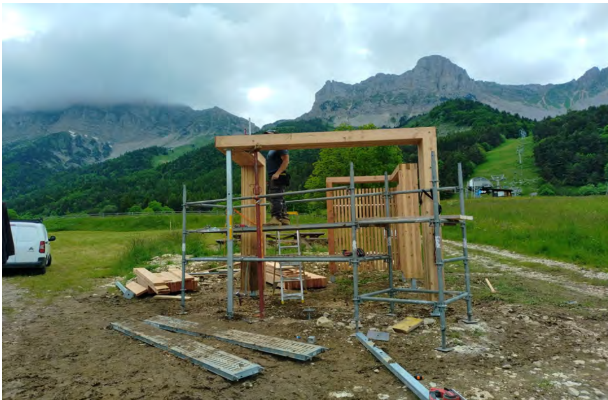
Chantier d'installation du mobilier à Gresse-en-Vercors
