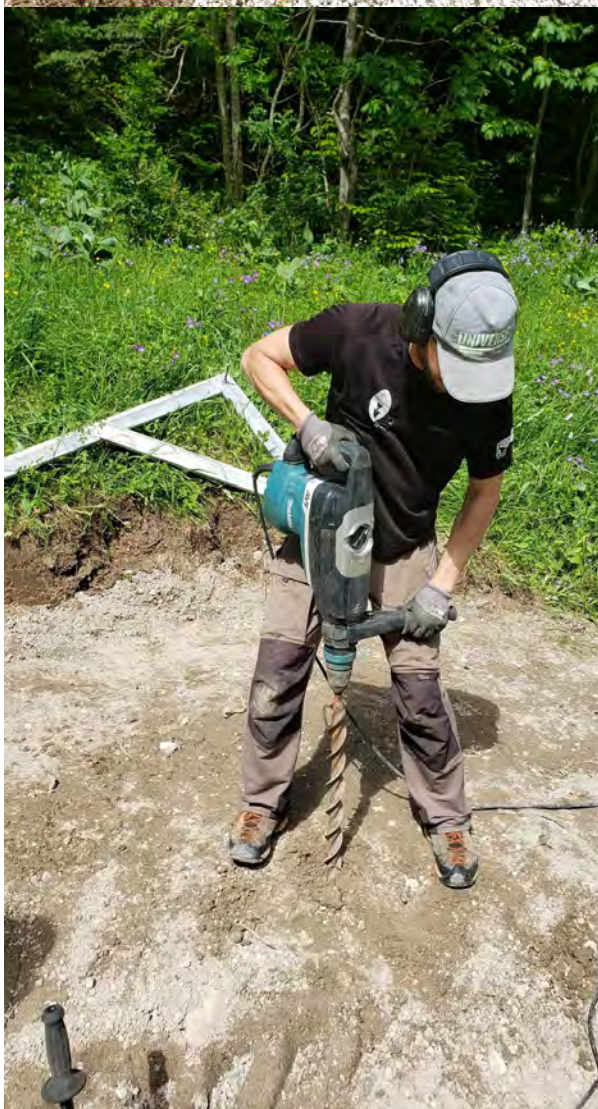
Préparation du sol et pose des vis sur le site de la Molière (commune d'Autrans Méaudre-en-Vercors).
