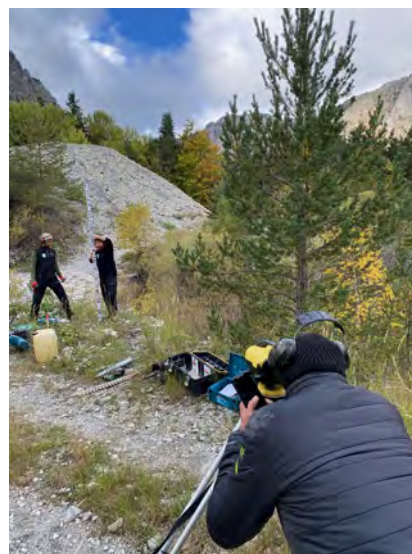
L'opération consiste à forer assez profondément dans le sol avec des diamètres de mèches différents pour élargir ensuite progressivement les trous. Différents gabarits sont utilisés pour être au plus juste. Les vis sont ensuite rentrées avec une grosse boulonneuse spéciale. La dernière étape consiste à mettre toutes les vis de niveau à l'aide d'une mire spéciale et d'un niveau optique.
