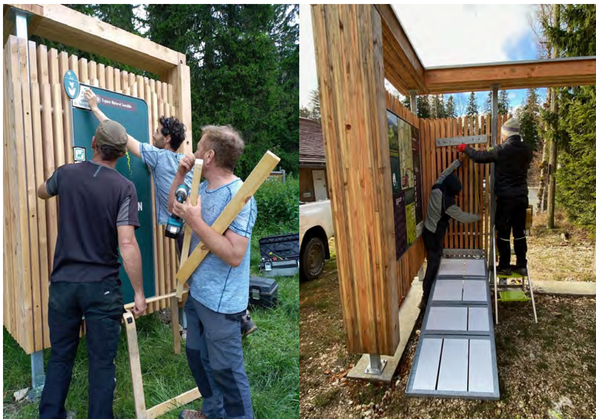
Pose de panneaux d'information sur la structure
