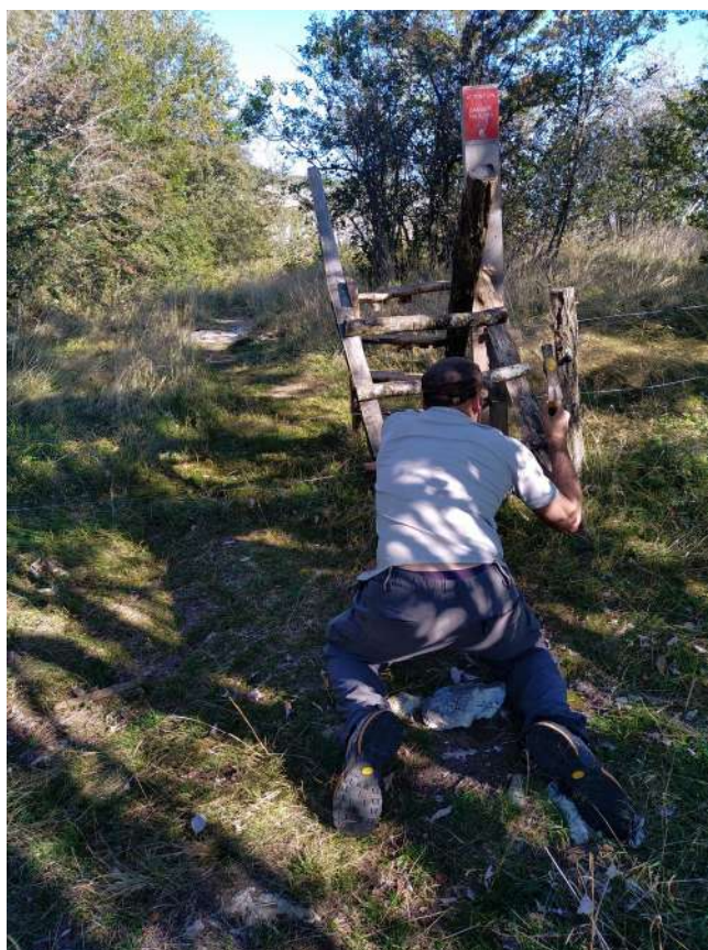
Réparation d'une échelle pour enjamber une clôture au col de la Machine
