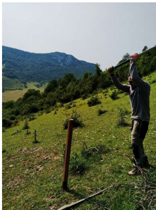
Pose de jalons
