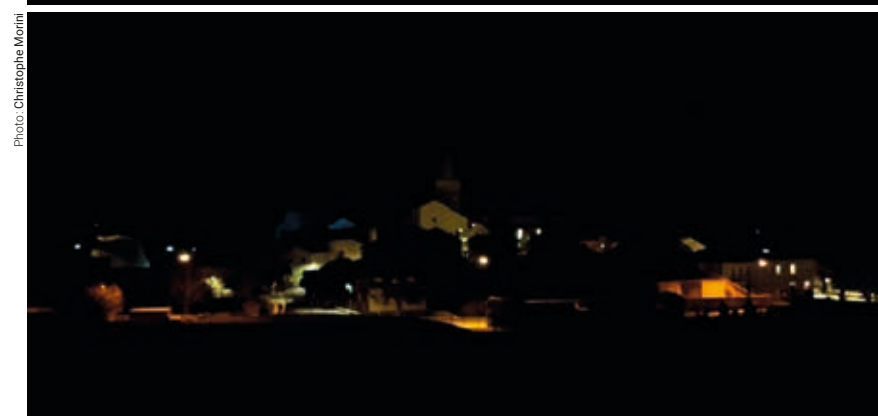
Le village de Saint-Agnan-en-Vercors avant et après la rénovation de l'éclairage public.
