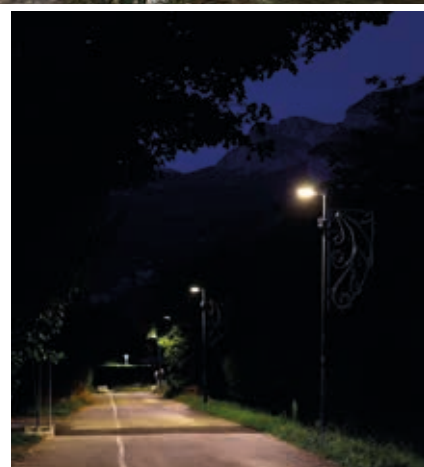
Éclairage dans une rue secondaire de Noyarey, LED à 2 800 Kelvins, extinction de minuit à 5 h. Les prochaines installations seront en 2 400 Kelvins.
